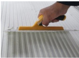
اجرای چسب پشت سرامیک با ماله دنداندار
