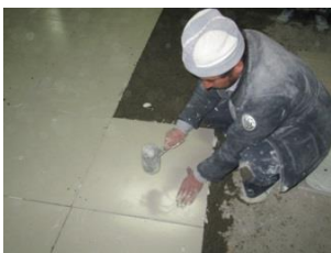
نصب سرامیک روی بستر ملات
