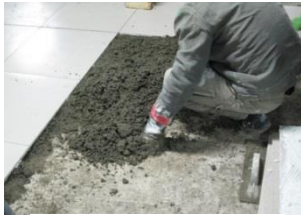
اجرای ملات ماسه-سیمان در کف
